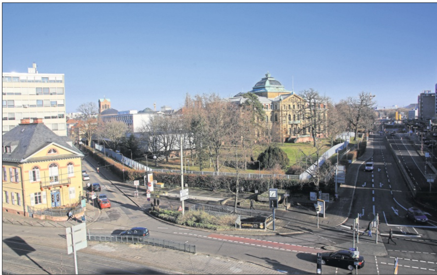
PLATZ GENUG wäre auf dem Areal des Bundesgerichtshofs an Herren- und Kriegsstraße für ein „Forum Recht“. Das Gebäude, wenn es denn kommt, soll einen Großteil der Freifläche einnehmen. Foto: jodo
