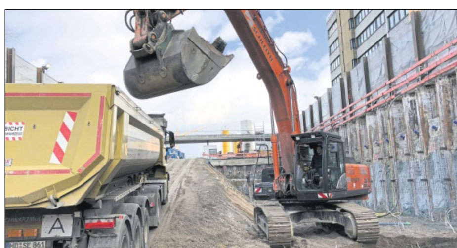
TIEFER DRINGT jetzt der Bagger unter das Niveau der Kriegsstraße vor, rechts der Hausblock, der bald einem Hotelbau weichen wird. Foto: Kasig
