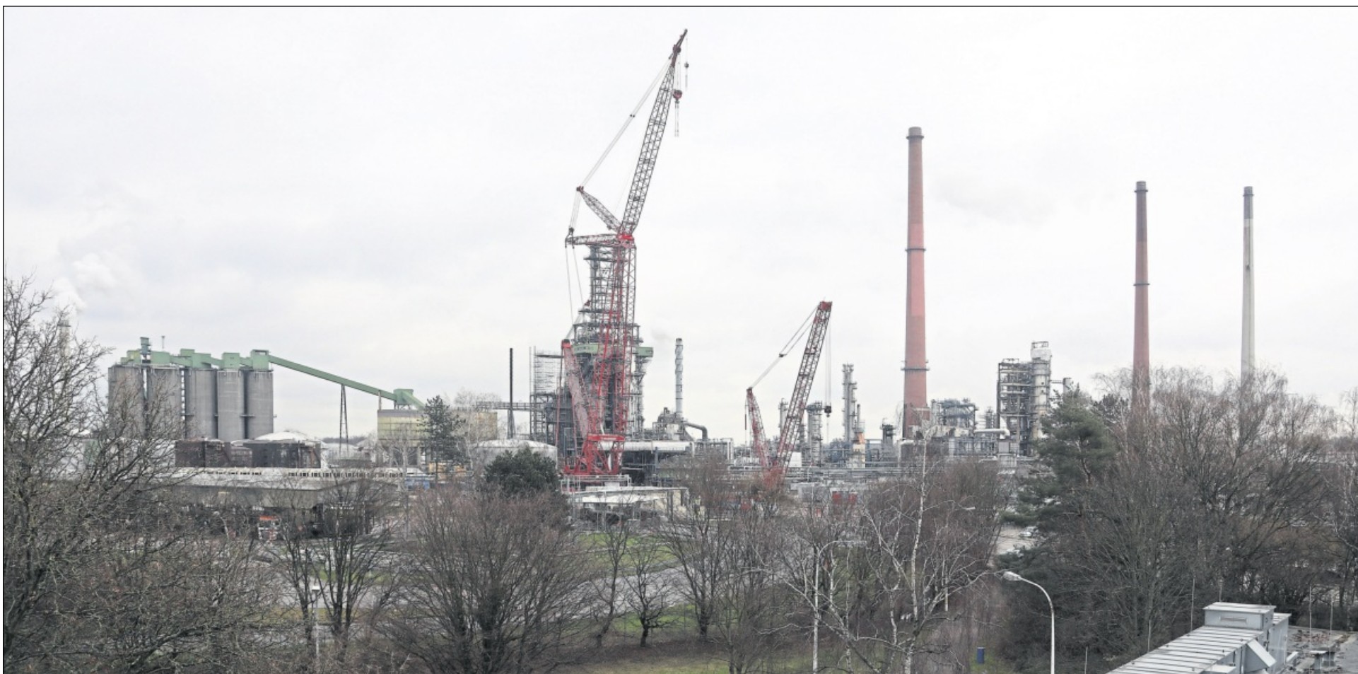
DIE SKYLINE DER MIRO hat sich deutlich verändert: Der Ringkran mit einer Hubkapazität von 2000 Tonnen ist bereits in seinem speziellen Fundament verankert und seit Mittwoch aufgerichtet. Er soll am zweiten Märzwochenende die beiden riesigen Kokstrommeln, die im Oktober geliefert wurden, in die Anlage hieven. Fotos: jodo
